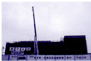
▲JR 横手駅工事
