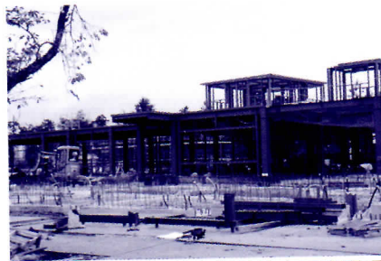
▲雄物川(館合)・社会福祉法人工事現場
