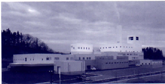
▶ クリーンプラザよこて
