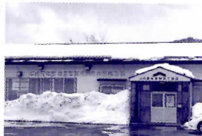
▲改修・増築される山内加工施設
